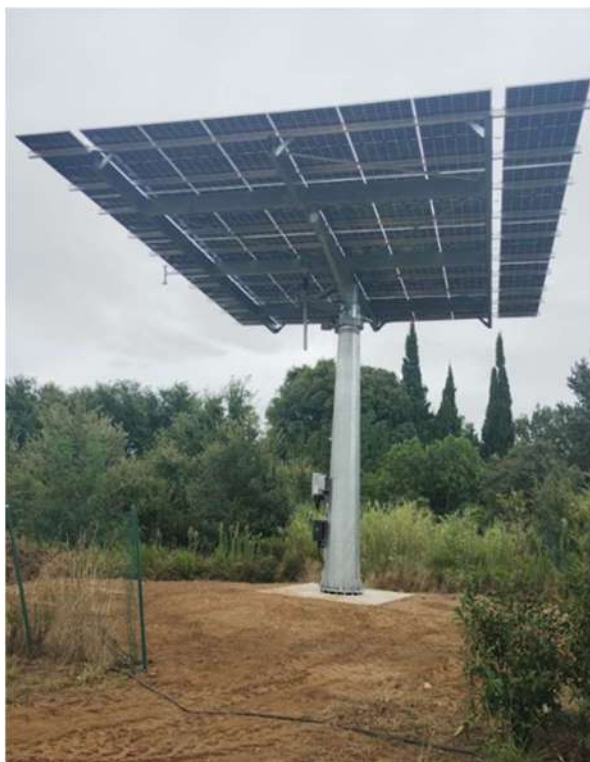
Pose d'un tracker à la station d'épuration de Ponteilla.
