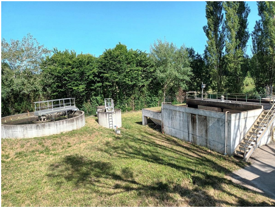
Station d'épuration de Lussac
