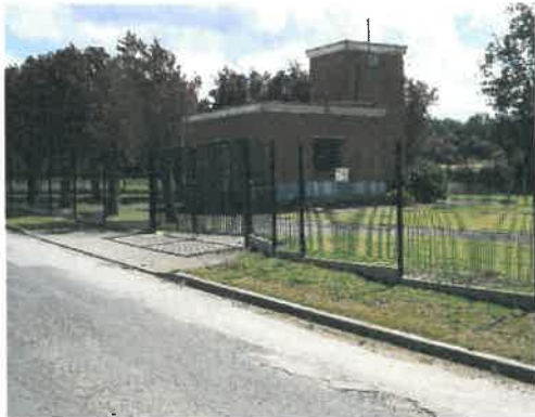
Station de Pompage à Nielles les Ardres
