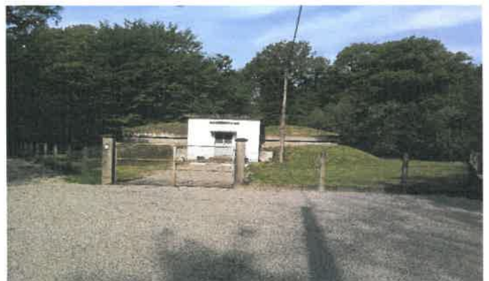
Réservoir de Recques Sur Hem
