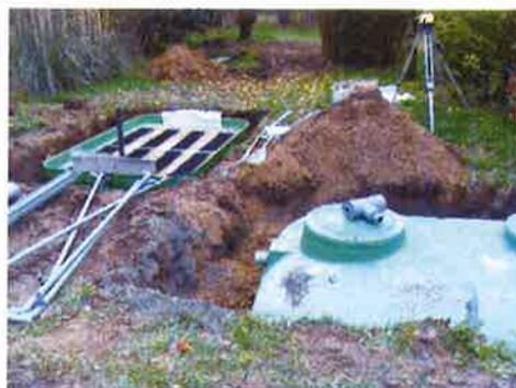
Mise en place d'une microstation
