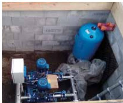
Ce dispositif a nécessité la création d'une canalisation de liaison et d'un poste de surpression enterré sous la rue du Petit Pont. L'ensemble est opérationnel depuis le mois de novembre 2018, à l'issue d'une phase de test et d'optimisation.
