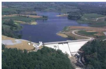
Les installations de pompage d'eau brute sont en fonctionnement depuis septembre 2000. La ressource principale du SERTAD provient du barrage de la Touche Poupard. L'eau est acheminée du barrage jusqu'au centre de potabilisation par l'intermédiaire d'une conduite en fonte d'un diamètre de soixante centimètres.
