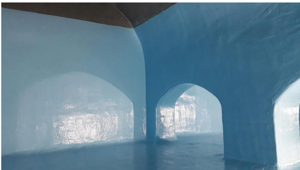
*Vue de l'intérieur d'une cuve après mise en place de la résine armée*
