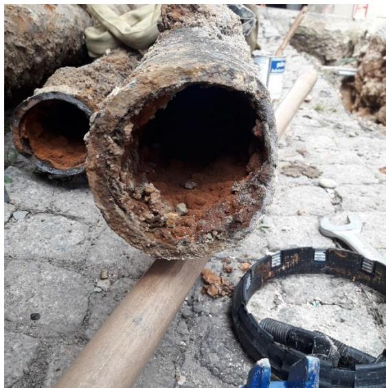
Travaux de renouvellement du réseau d'eau potable de la rue du Château à ZELLWILLER – DN 200 mm
